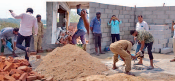
చౌదరిగూడలో ఆక్రమ నిర్మాణాలను కూల్చివేయస్తున్న డిఎల్‌పిఓ సాంబిరెడ్డి, ఎంపిఓ, రమికుమార్
