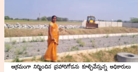
ఆక్రమంగా నిర్మించిన ప్రవారిగోడను కూల్చివేస్తున్న అధికారులు
